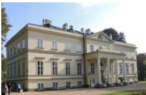
Kostelec nad Orlicí – hlavní průčelí
