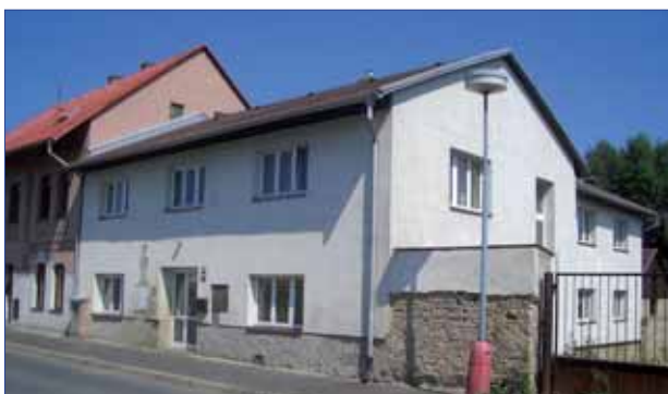
Nový objekt Centra terénního výzkumu v Mělníce
