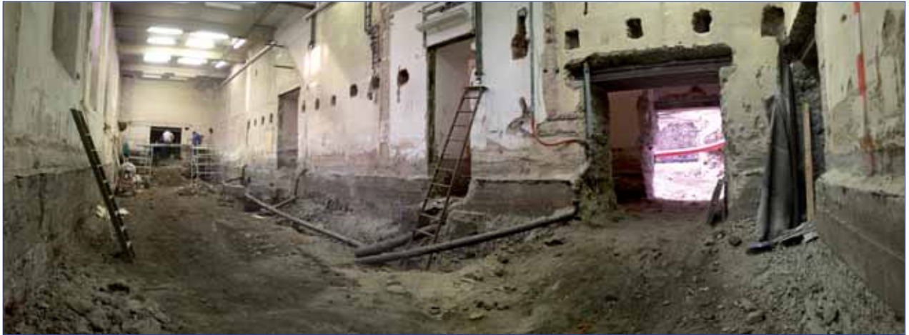
Druhý suterén v průběhu stavby
